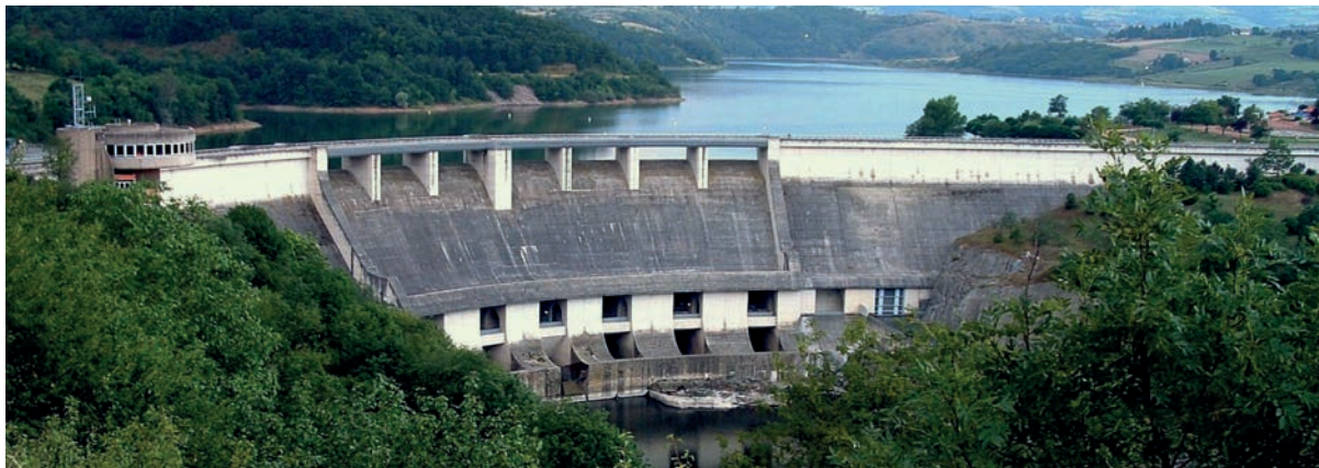
Barrage de Villerest
